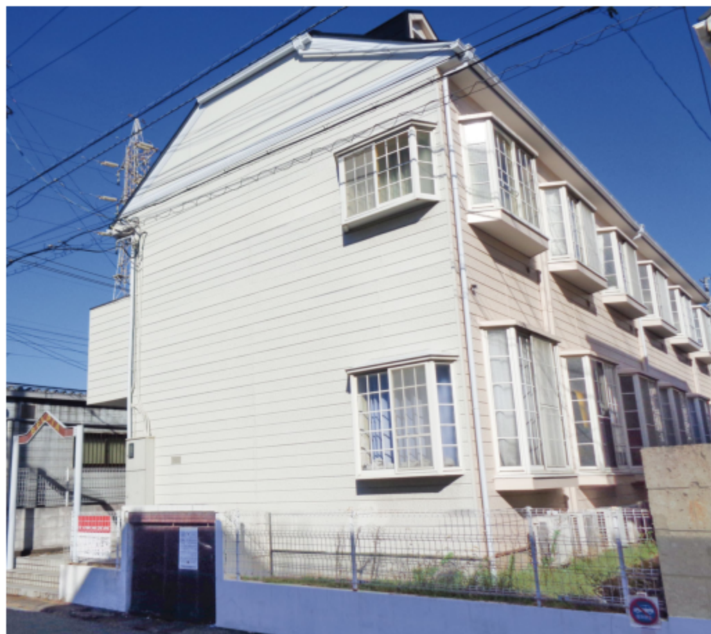
※写真は全て現地にて撮影したものです。(令和4年1月撮影)
