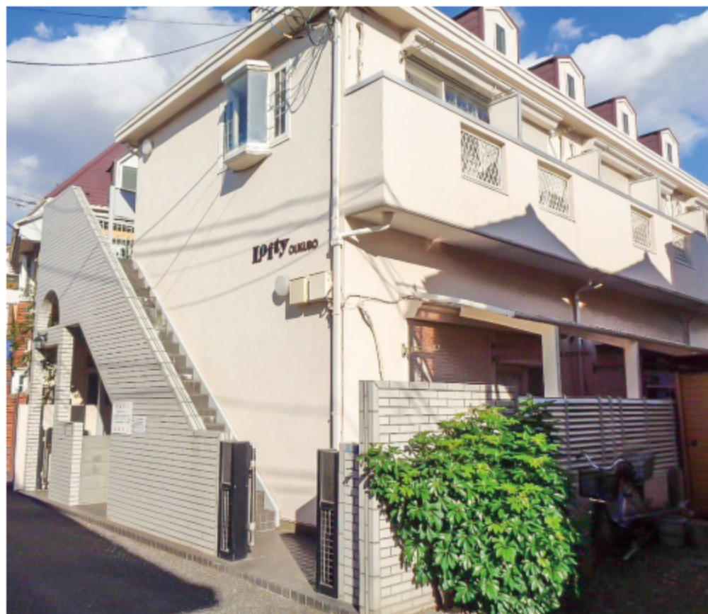
※写真は全て現地にて撮影したものです。(令和3年11月撮影)
