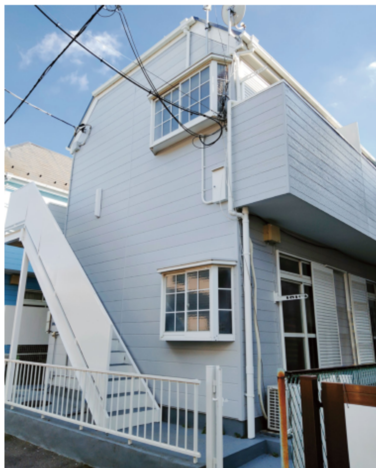
※写真は全て現地にて撮影したものです。(令和3年10月撮影)
