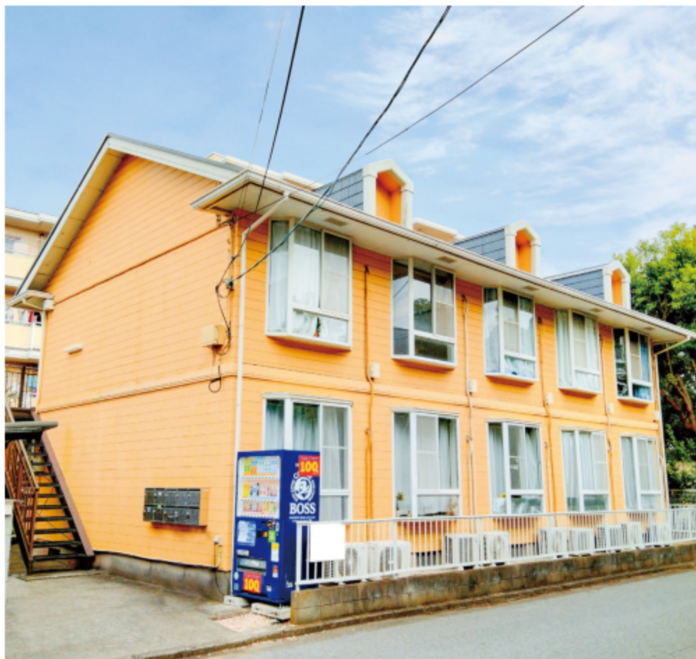
※写真は全て現地にて撮影したものです。(令和3年10月撮影)
