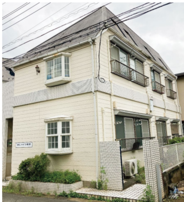
※写真は全て現地にて撮影したものです。(令和3年8月撮影)
