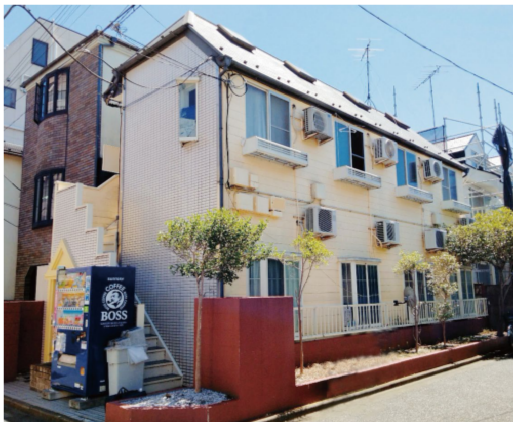
※写真は全て現地にて撮影したものです。(令和3年8月撮影)
