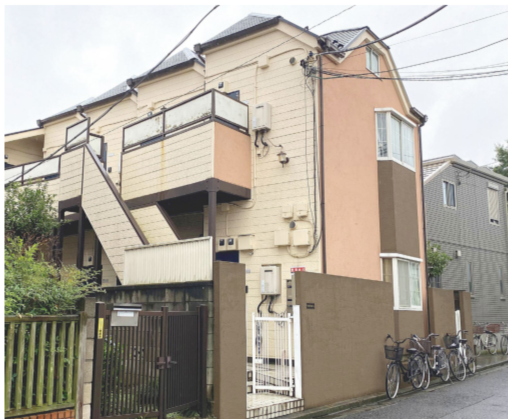
※写真は全て現地にて撮影したものです。(令和3年7月撮影)
