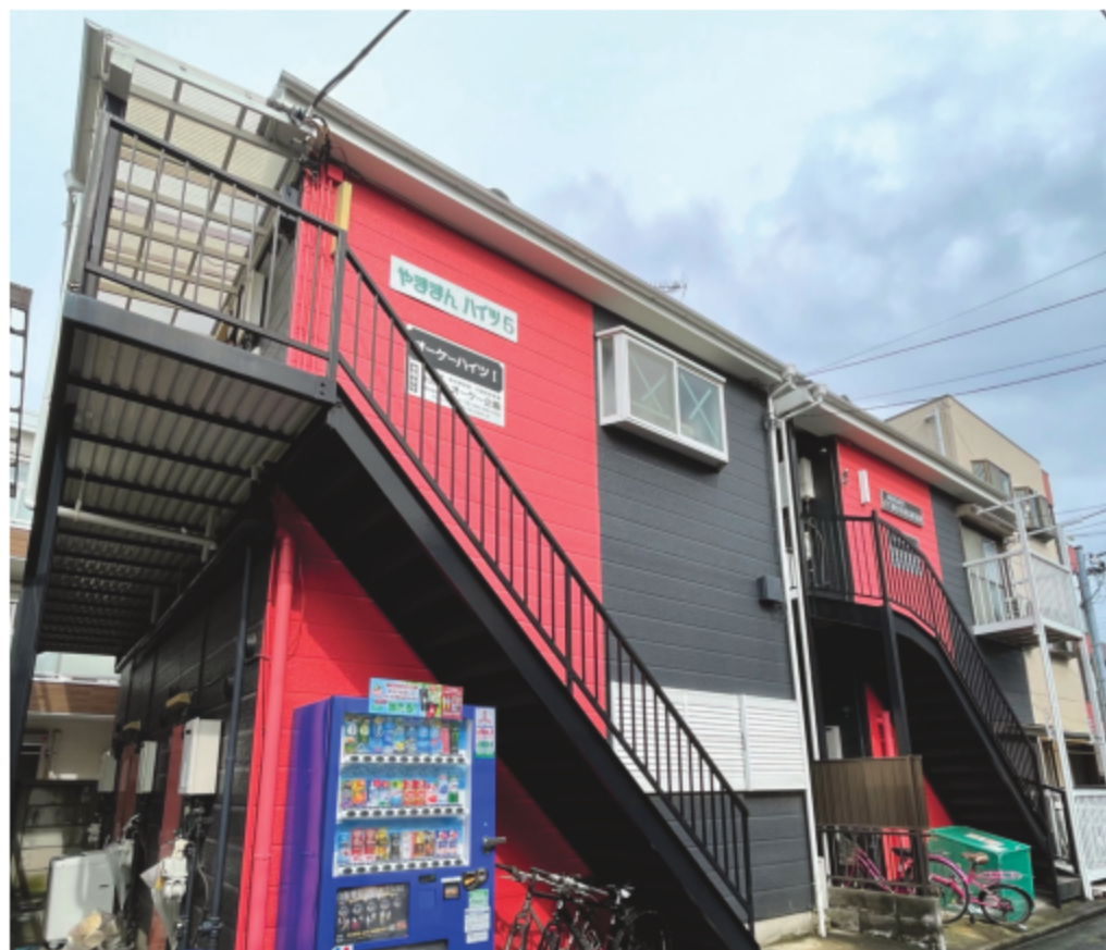
※写真は全て現地にて撮影したものです。(令和3年7月撮影)
