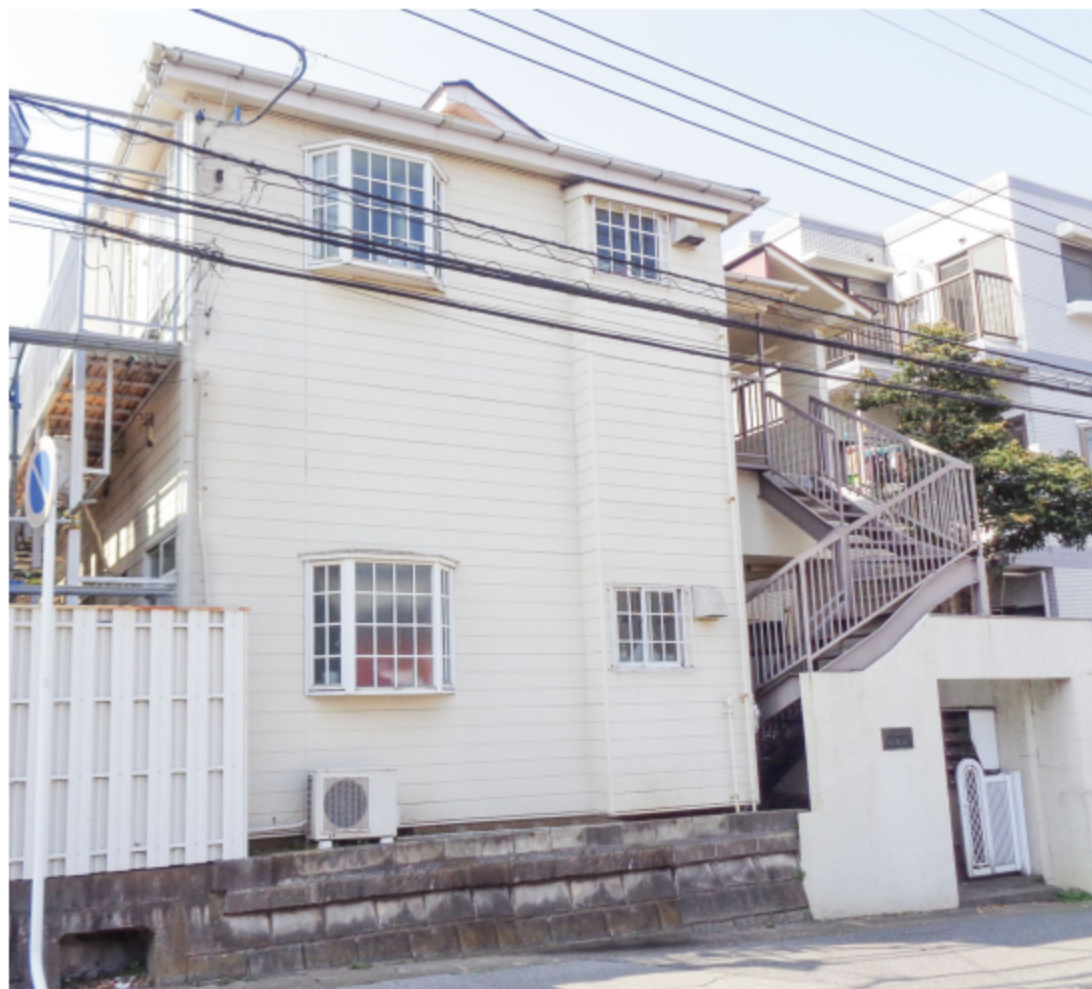
※写真は全て現地にて撮影したものです。(令和4年3月撮影)
