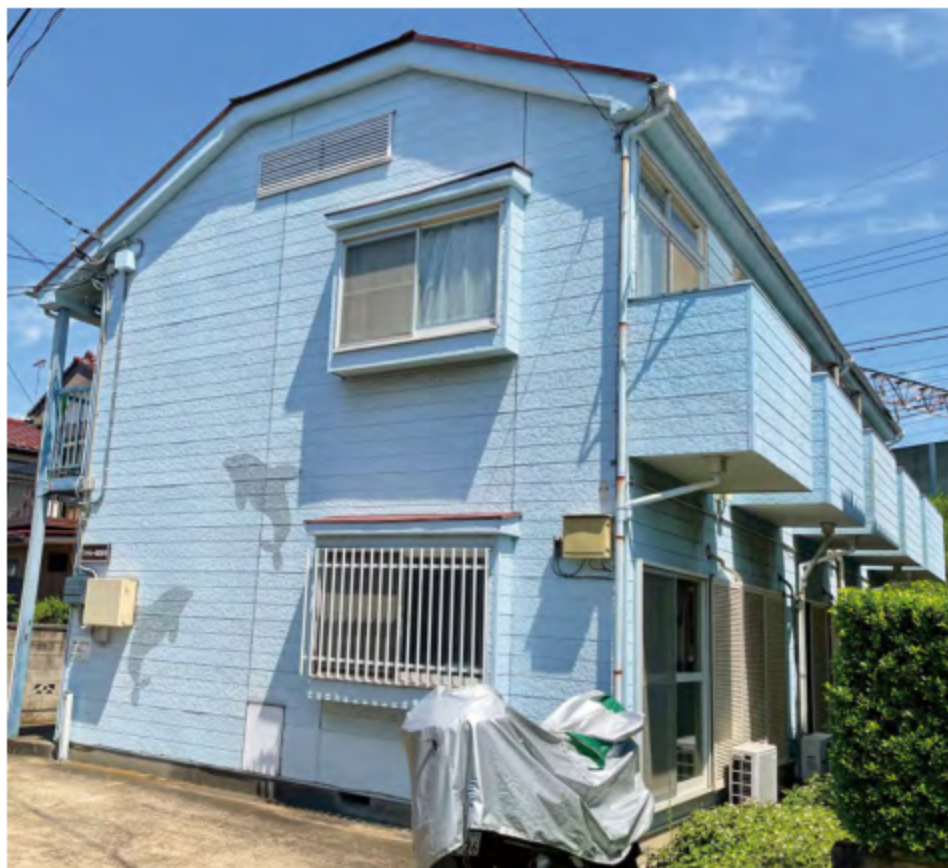
※写真は全て現地にて撮影したものです。(令和4年5月撮影)
