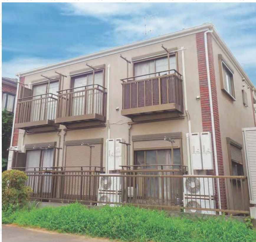
※写真は全て現地にて撮影したものです。(令和4年7月撮影)
