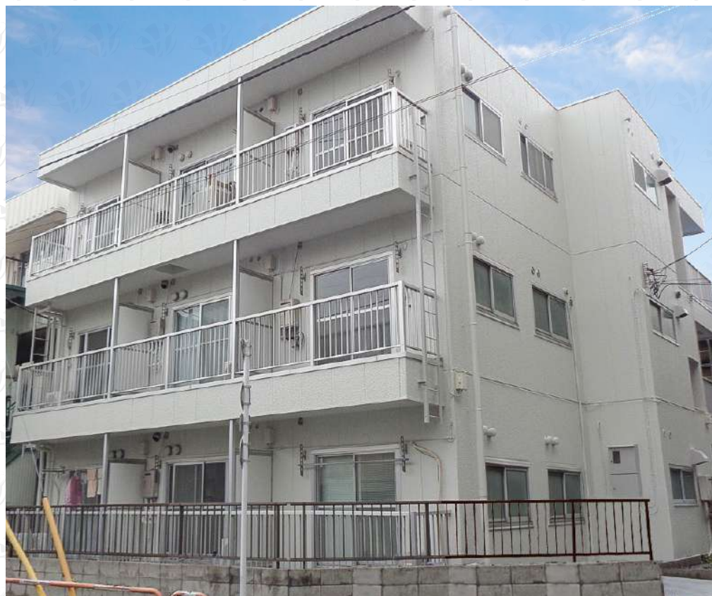
※写真は全て現地にて撮影したものです。(令和4年6月撮影)
