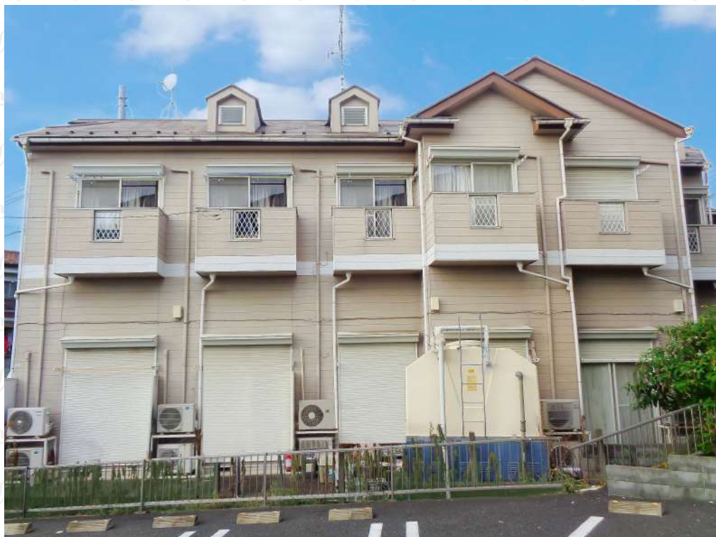
※写真は全て現地にて撮影したものです。(令和4年8月撮影)
