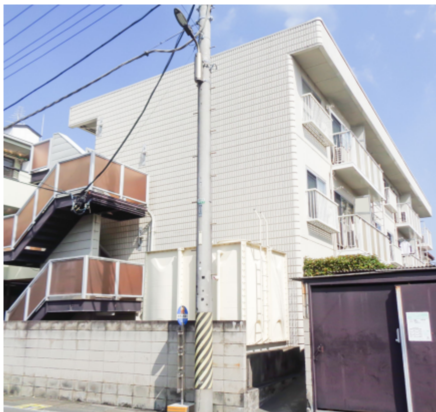
※写真は全て現地にて撮影したものです。(令和4年2月撮影)
